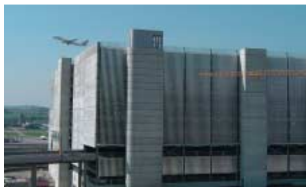
Parking de Kloten, construction en acier, jusqu'à 20 m de long, total 5'000 t.
